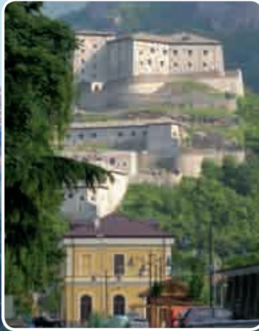
Ostello della Gioventù con il Forte di Bard sullo sfondo
