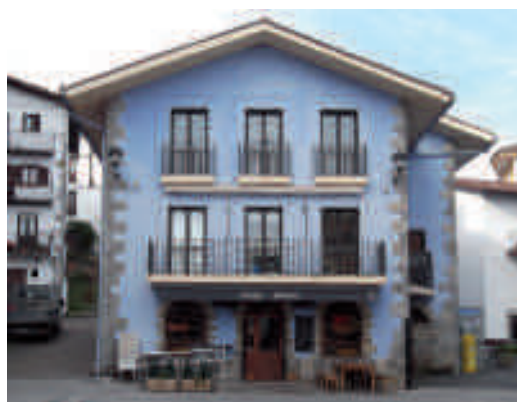
EDIFICIO JAUREGI - AIA Tel.: 00 34 - 943 131 144 aia@aia.eus 10/11 - 04 - 2015
